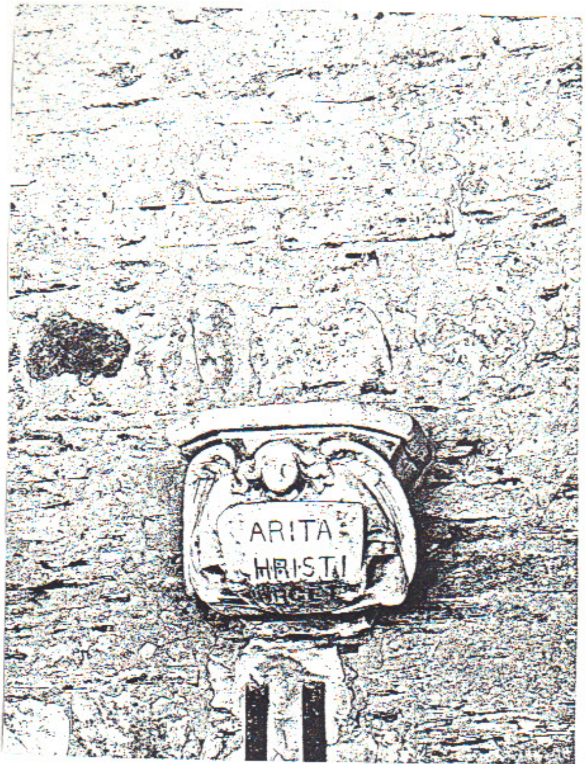
fig.11 Culot médian, première travée, mur nord, chapelle de Beauvau, église du couvent des Augustins d'Angers. (Cl. Inv. LASA-GIRAUD 80-49-2898 X)
